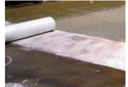
FRP防水工事施工現場
